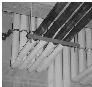
Foto: Ejecución correcta de montantes con aislación y sujeciones.
