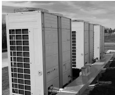
Foto: protección mecánica de cañerías al exterior.
