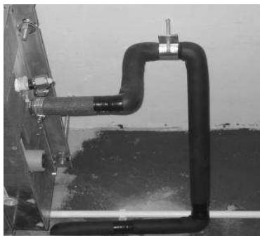
Foto: Ejecución correcta de desagüe de condensado de unidad evaporadora baja silueta.
