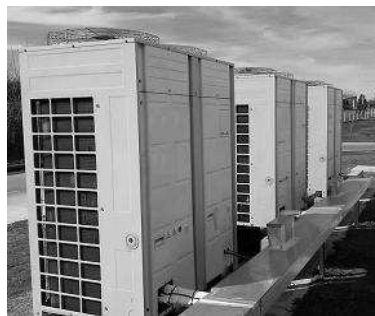
Foto: protección mecánica de cañerías al exterior.
