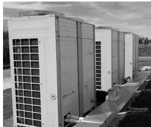
Foto: protección mecánica de cañerías al exterior.
