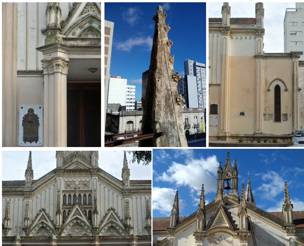
Deterioro generalizado, ampollamiento, desprendimiento, fisuración y disgregación de revoques exteriores. Desprendimiento de ornamentación premoldeada. Grietas y fisuras en fachadas sobre calle 5 – Degradación de capas pictóricas
