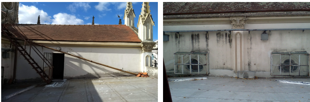
Cubiertas con pendientes hacia el interior del edificio. Deterioro de membranas. Pérdida de plano de escurrimiento
