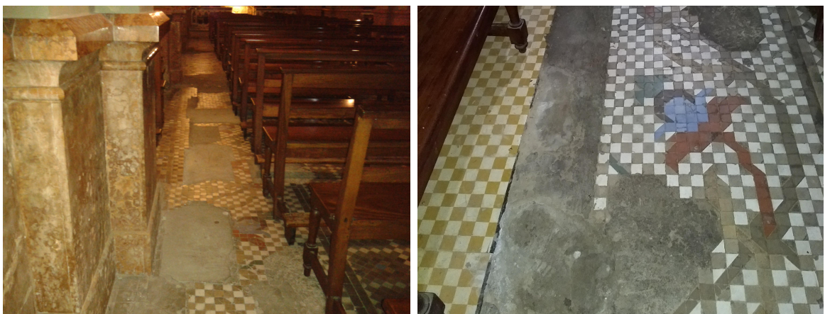
Parcheos en pisos y degradación de mármoles
