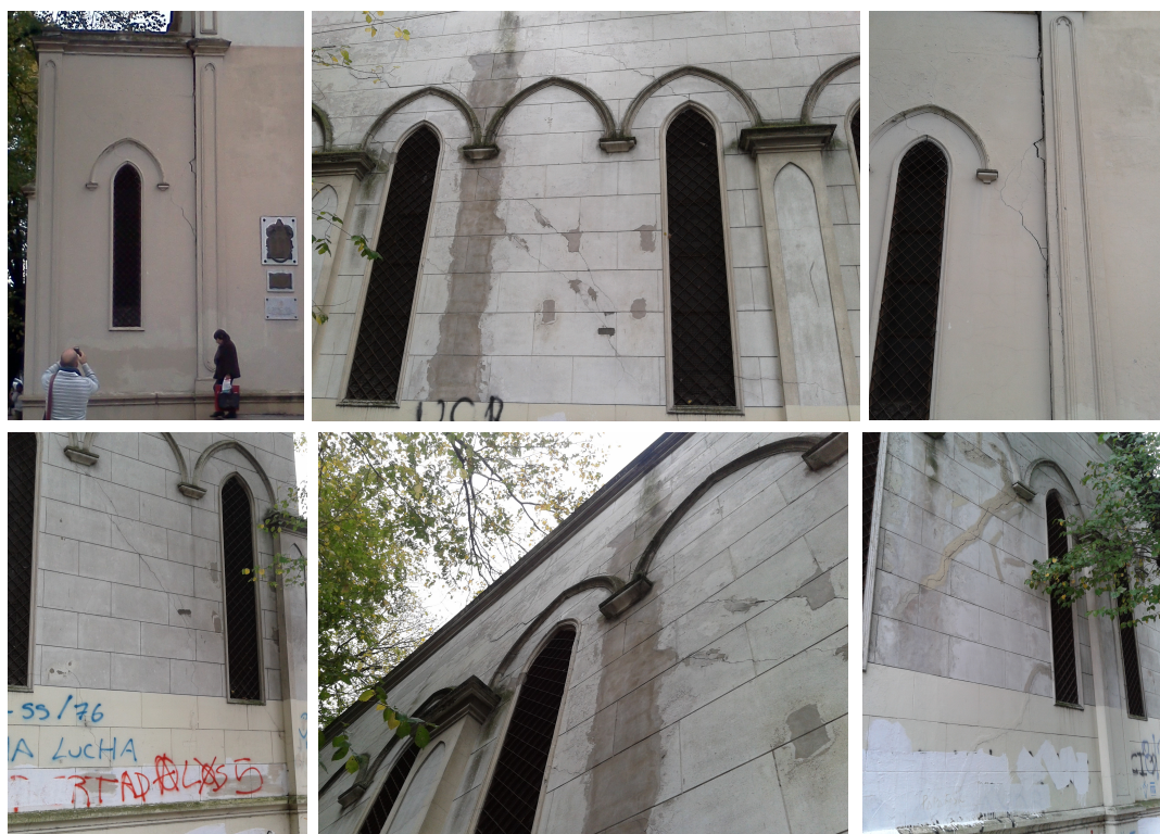
Deterioro generalizado, ampollamiento, desprendimiento, fisuración y disgregación de revoques exteriores. Desprendimiento de ornamentación premoldeada. Grietas y fisuras en fachadas sobre calle 5 – Degradación de capas pictóricas
