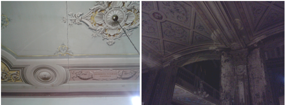
Degradación de cielorrasos: Fisuración, ampollamiento, disgregación, deterioro de capa pictórica
