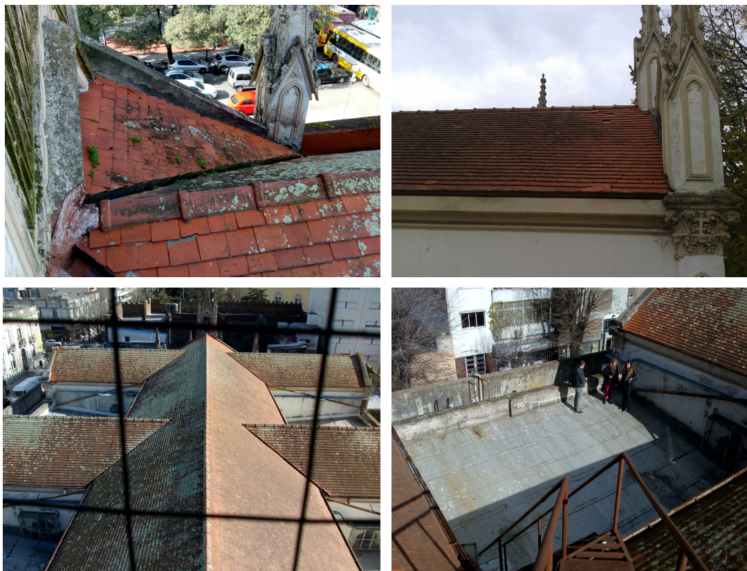
Deterioros y faltantes en cubierta de tejas. Obsolescencia, obstrucción y falta de sección de desagües pluviales
