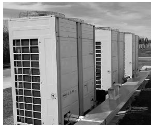
Foto: protección mecánica de cañerías al exterior.
