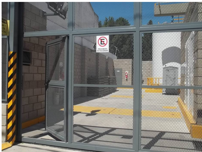
*Estación de Bombeo Cloacal Magdalena – Metal desplegado tipo Shulman
