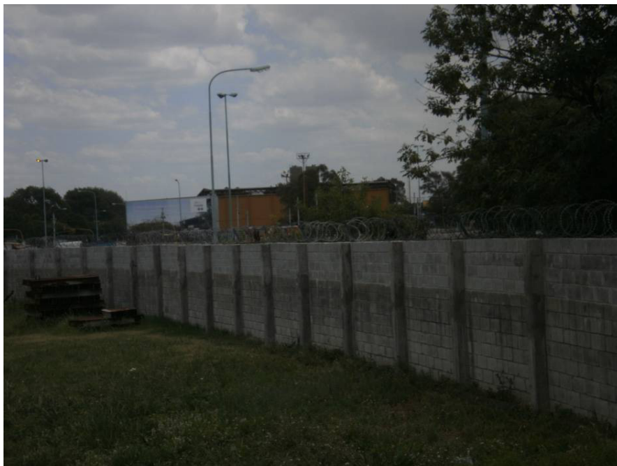
*Establecimiento Varela – Muro perimetral bloques de hormigón con alambre tipo concertina
