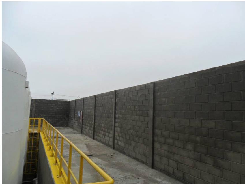
*Estación de Bombeo Cloacal Ramal Quilmes – Muro perimetral bloques de hormigón
