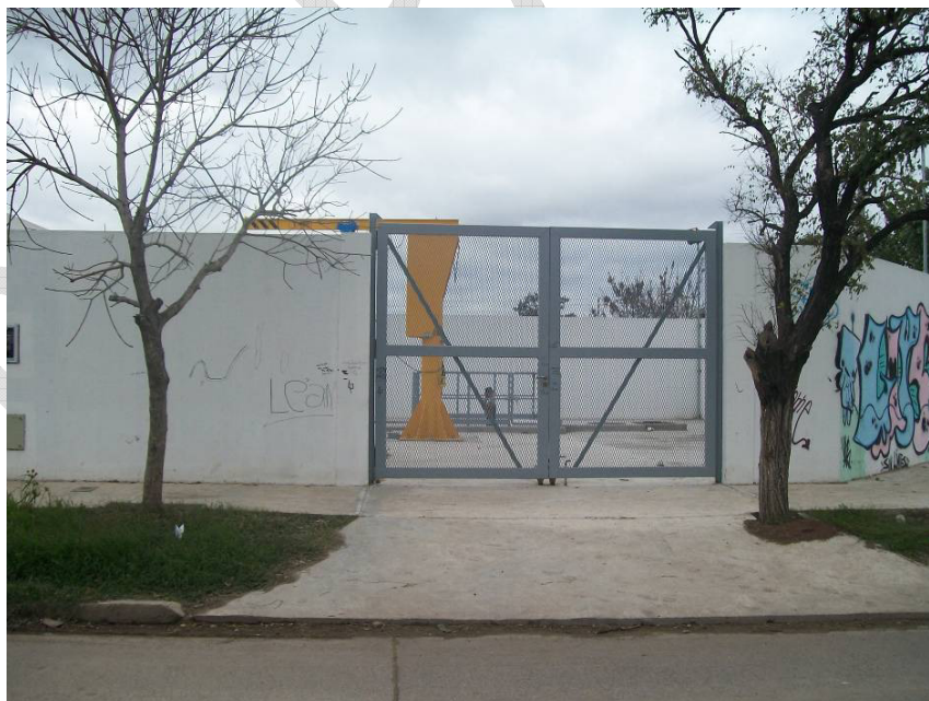
*Planta de Bombeo Cloacal Algarrobo – Metal desplegado tipo Shulman (misma altura muro perimetral)
