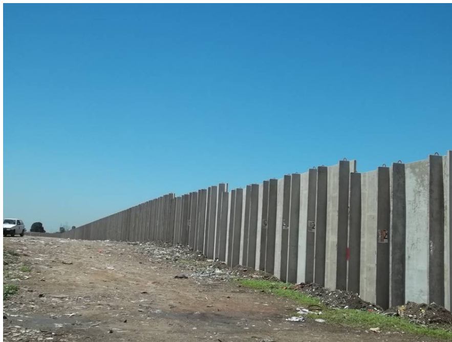
*Planta Depuradora Fiorito – Muro de hormigón premoldeado panel nervurado
