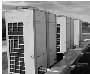
Foto: protección mecánica de cañerías al exterior.
