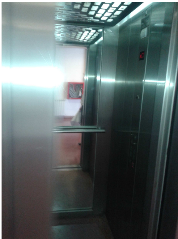
Fig. Puertas de Acero inoxidable a proveer e instalar. Ac inox. 304 18/8 antimagnético
