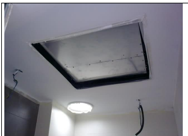
Foto 3: acceso a mantenimiento de unidades evaporadoras
