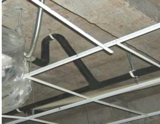
Foto 5: Ejecución correcta del tendido de la cañería de drenaje con aislamiento y sujeciones.
