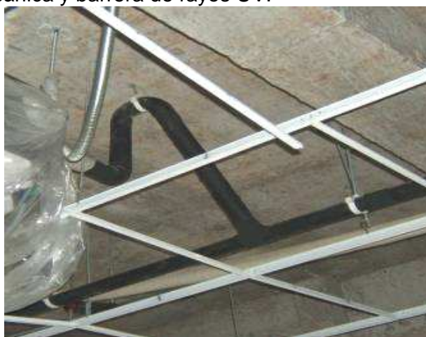
Foto 5: Ejecución correcta del tendido de la cañería de drenaje con aislación y sujeciones.
