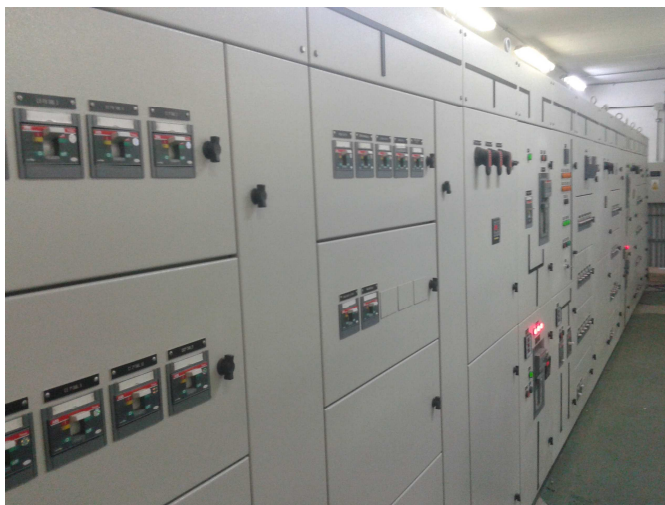
Fig. Tablero General en Cámara Transformadora
